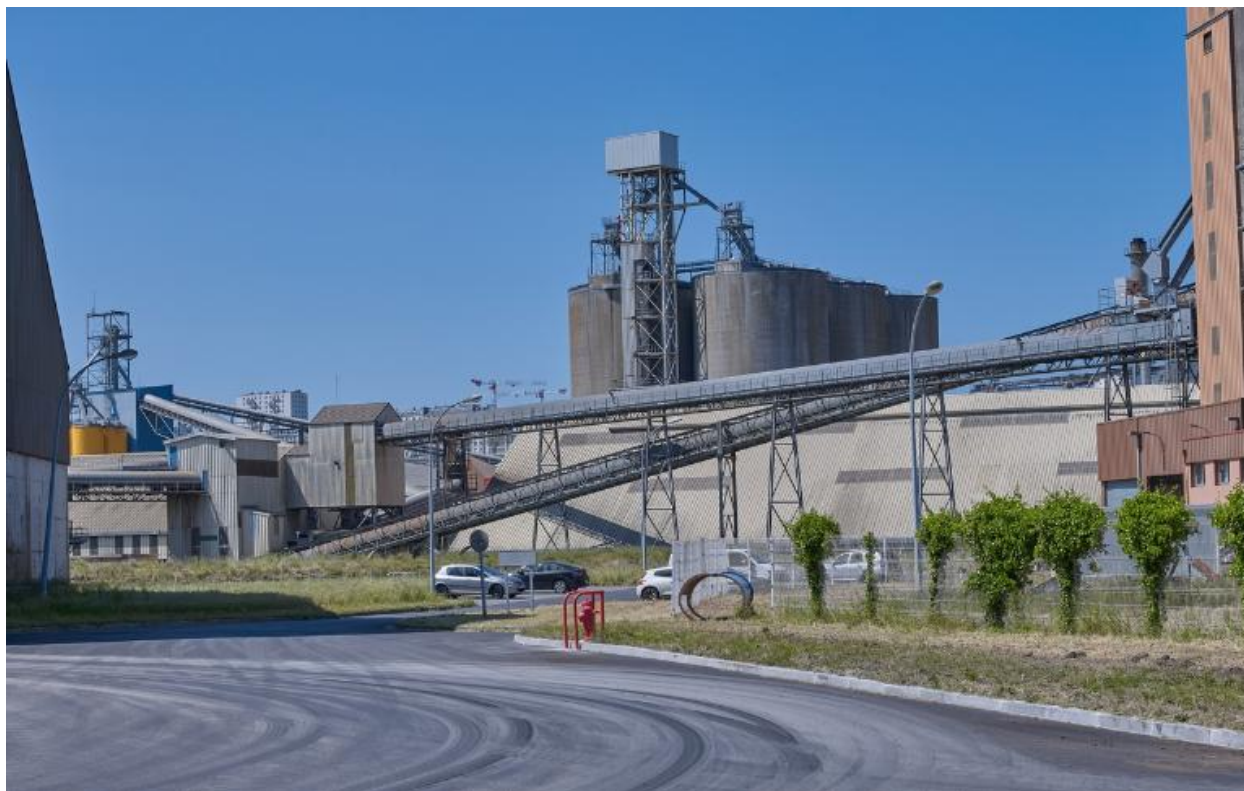
Silos, magasins de stockage, bandes transporteuses, tour de liaison
