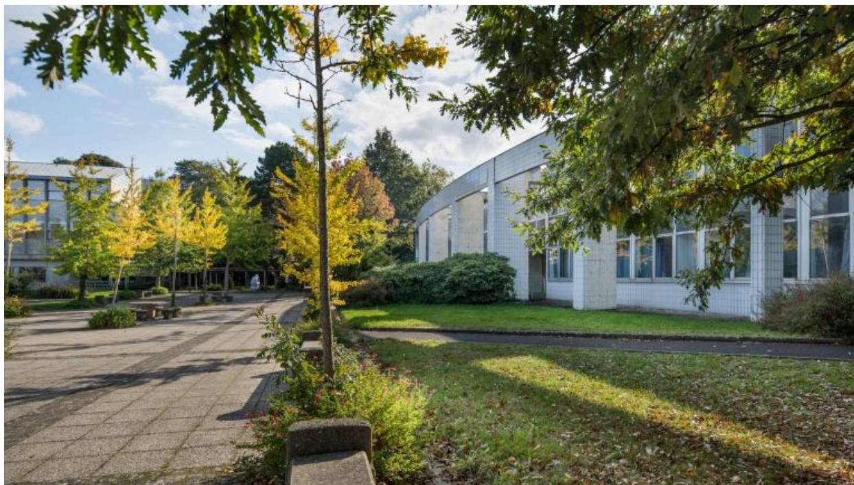
Vue d'ensemble prise du nord : cour, pôle sciences et CDI.
