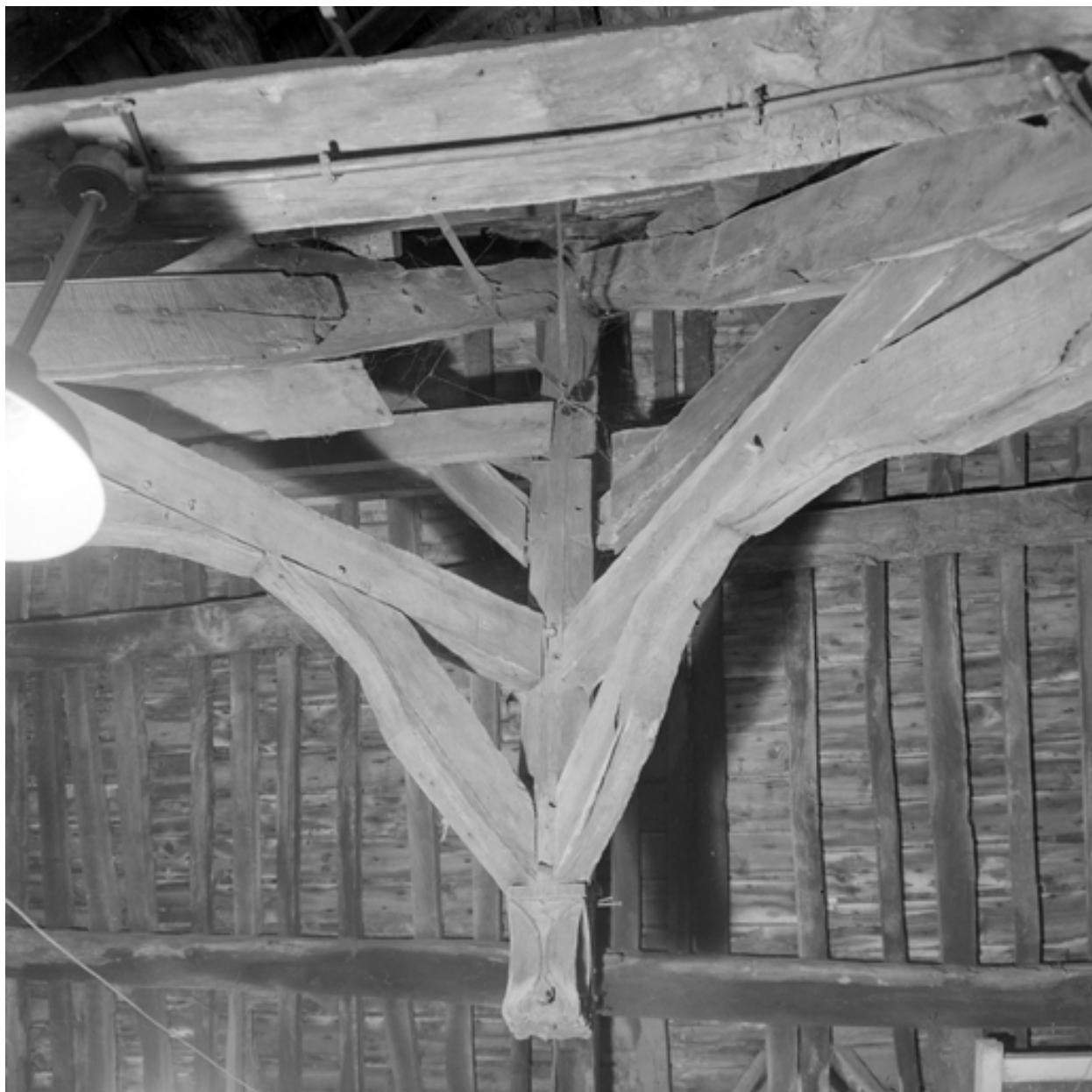
Charpente, détail de l'assemblage central.
