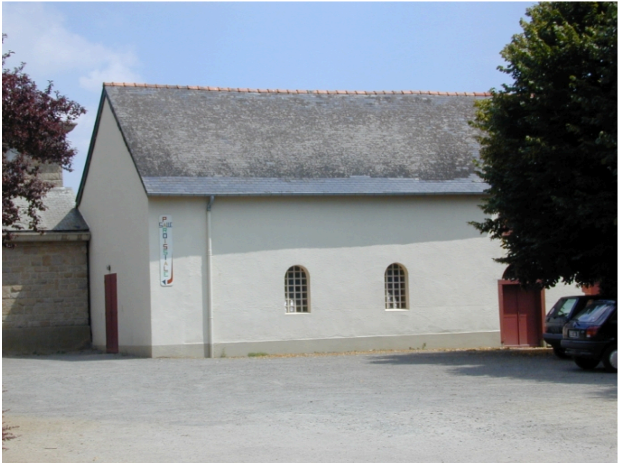
Ancienne dépendance transformée en salle paroissiale
