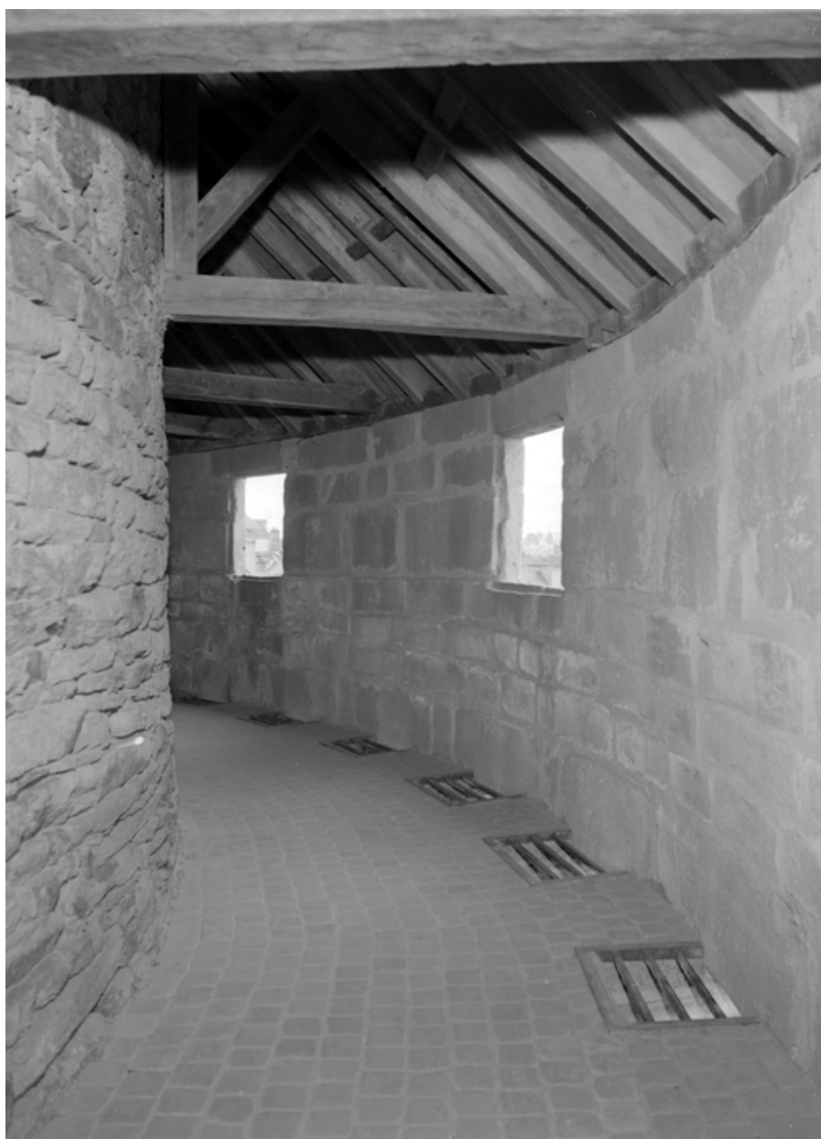
Tour sud-ouest, chemin de ronde.
