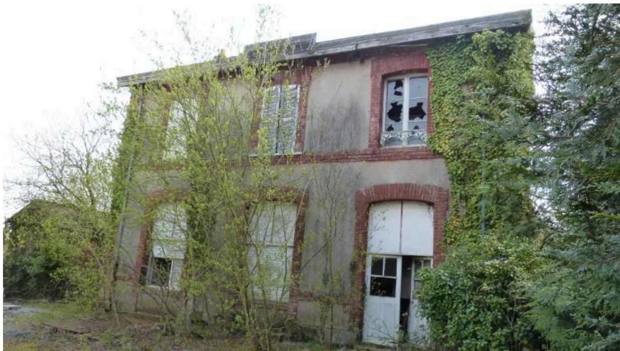
Ancienne gare de Pleine-Fougères - Façade nord
