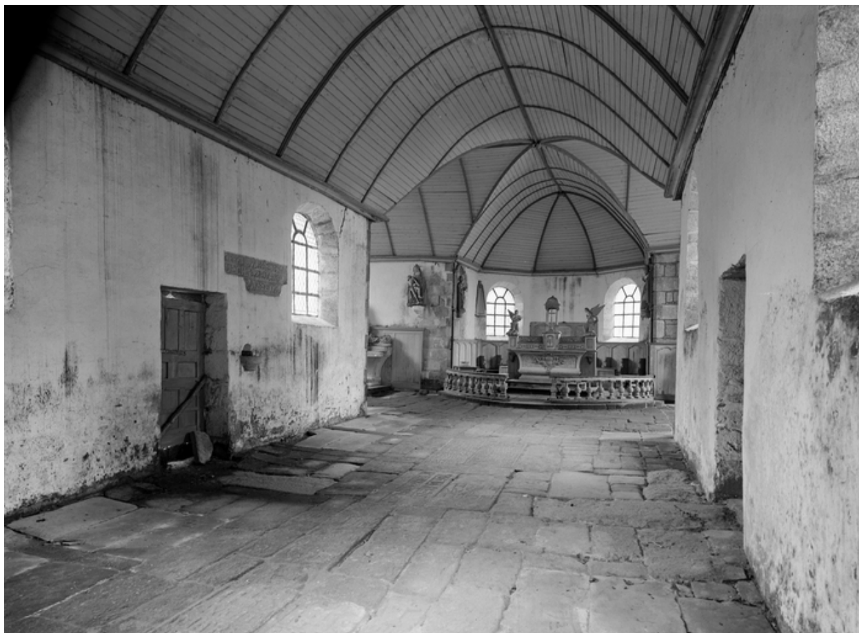
Vue intérieure vers l'est
