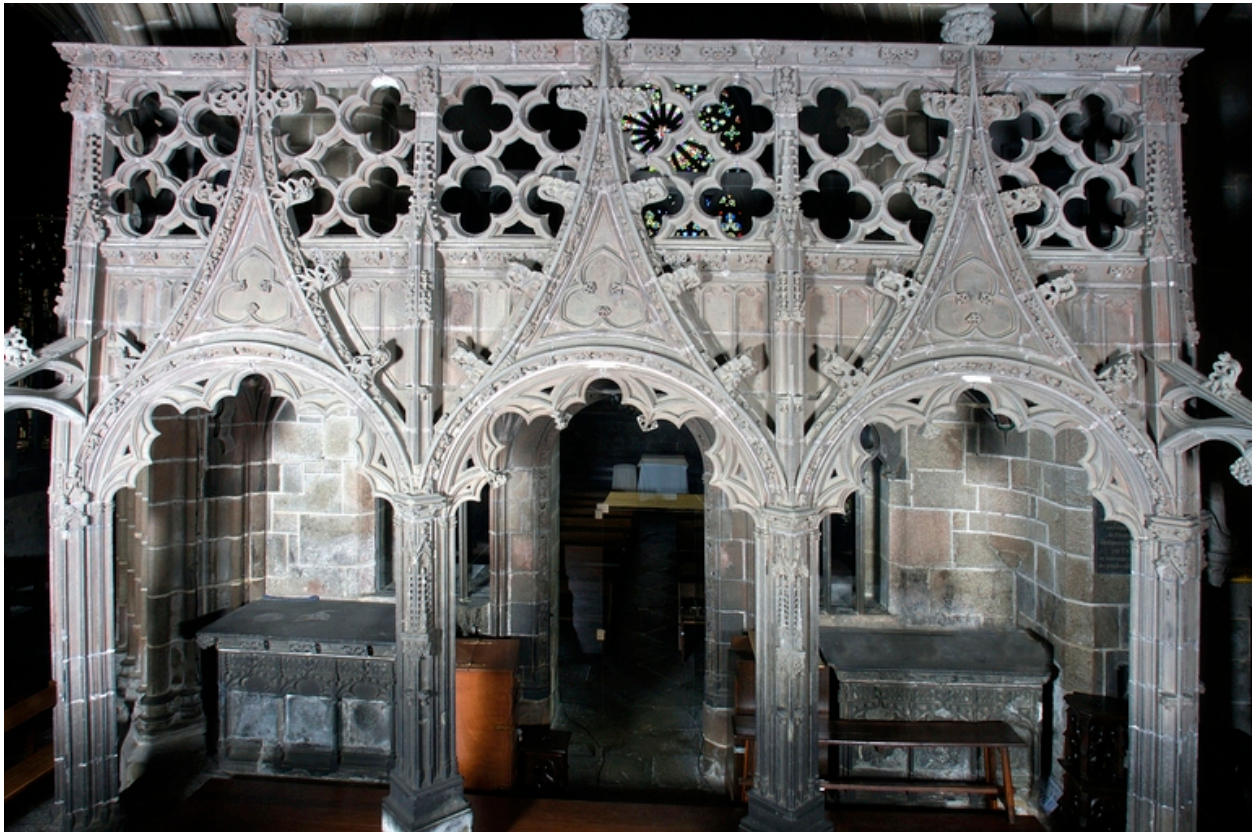
Façade ouest du jubé
