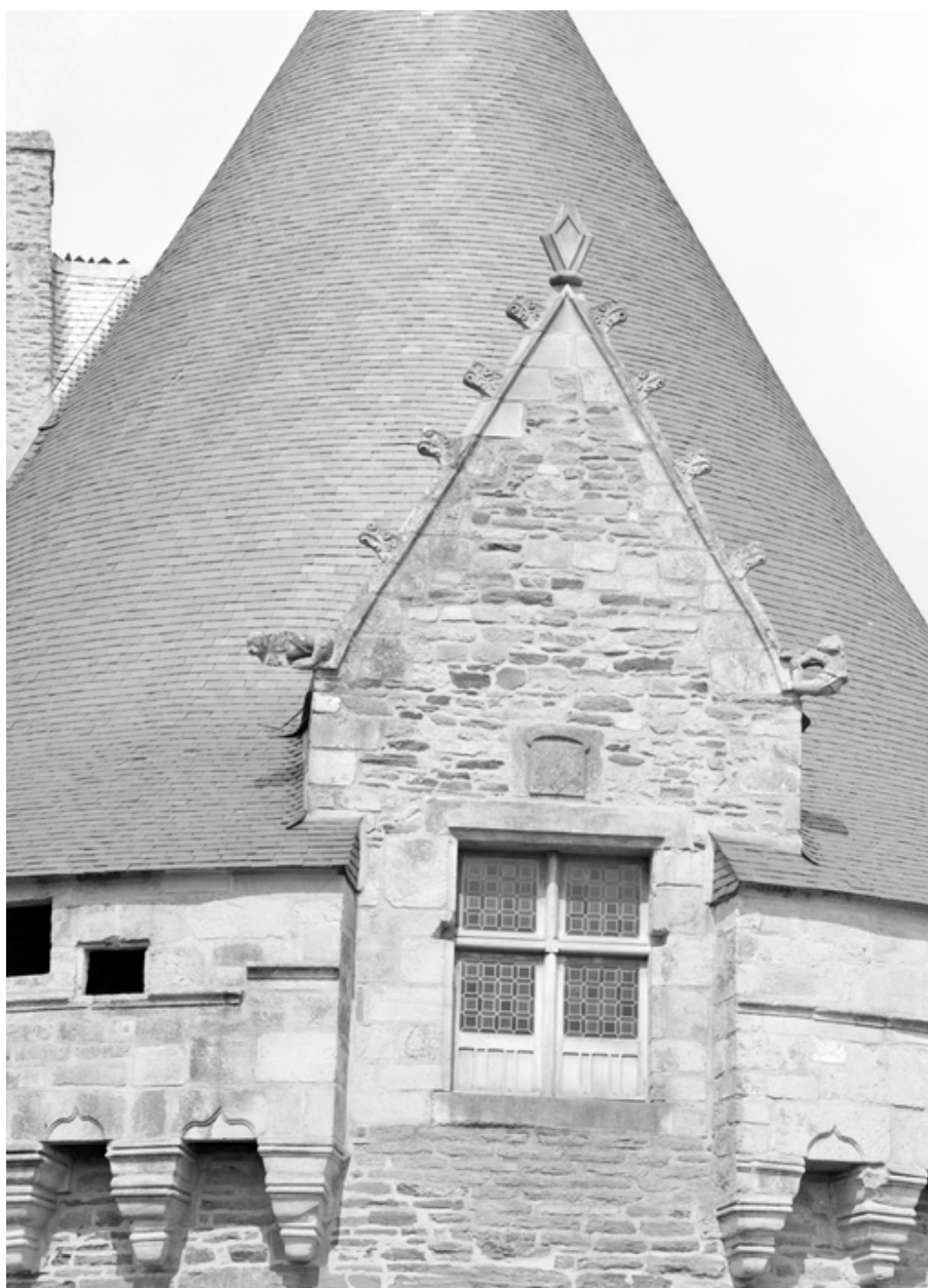
Lucarne de la tour sud-ouest.
