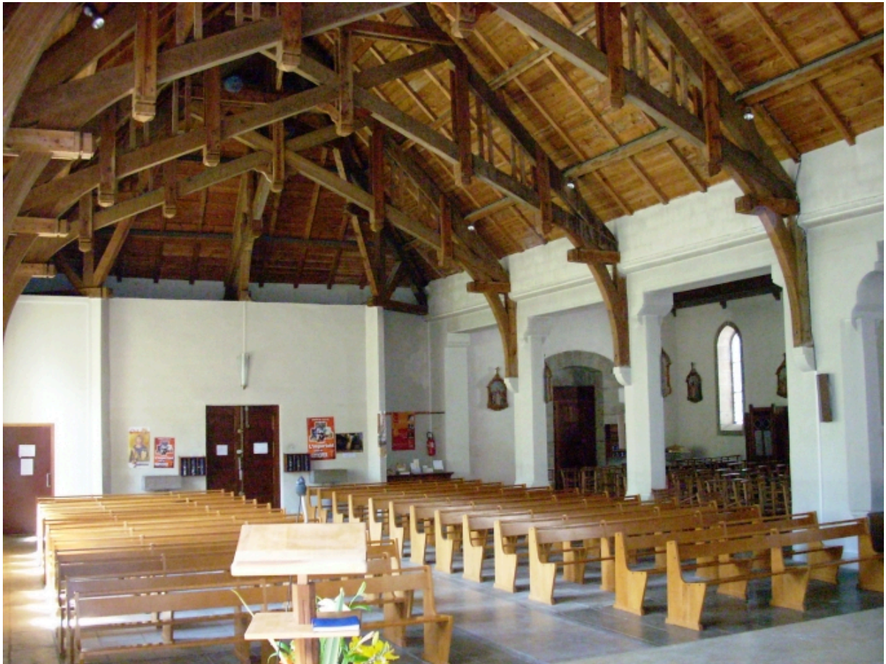
Ploudalmézeau, église de Portsall : vue transversale de la nef vers le nord-ouest
