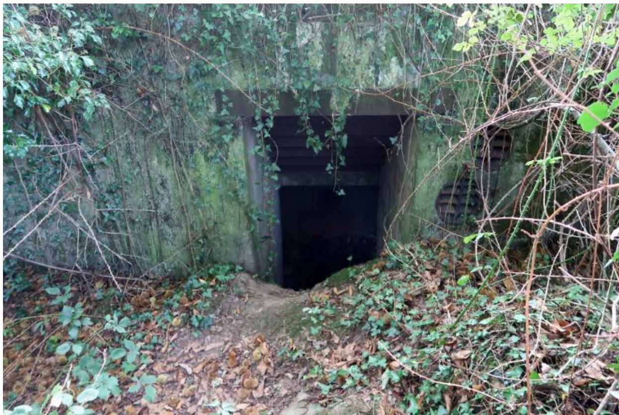
Vue de l'entrée nord
