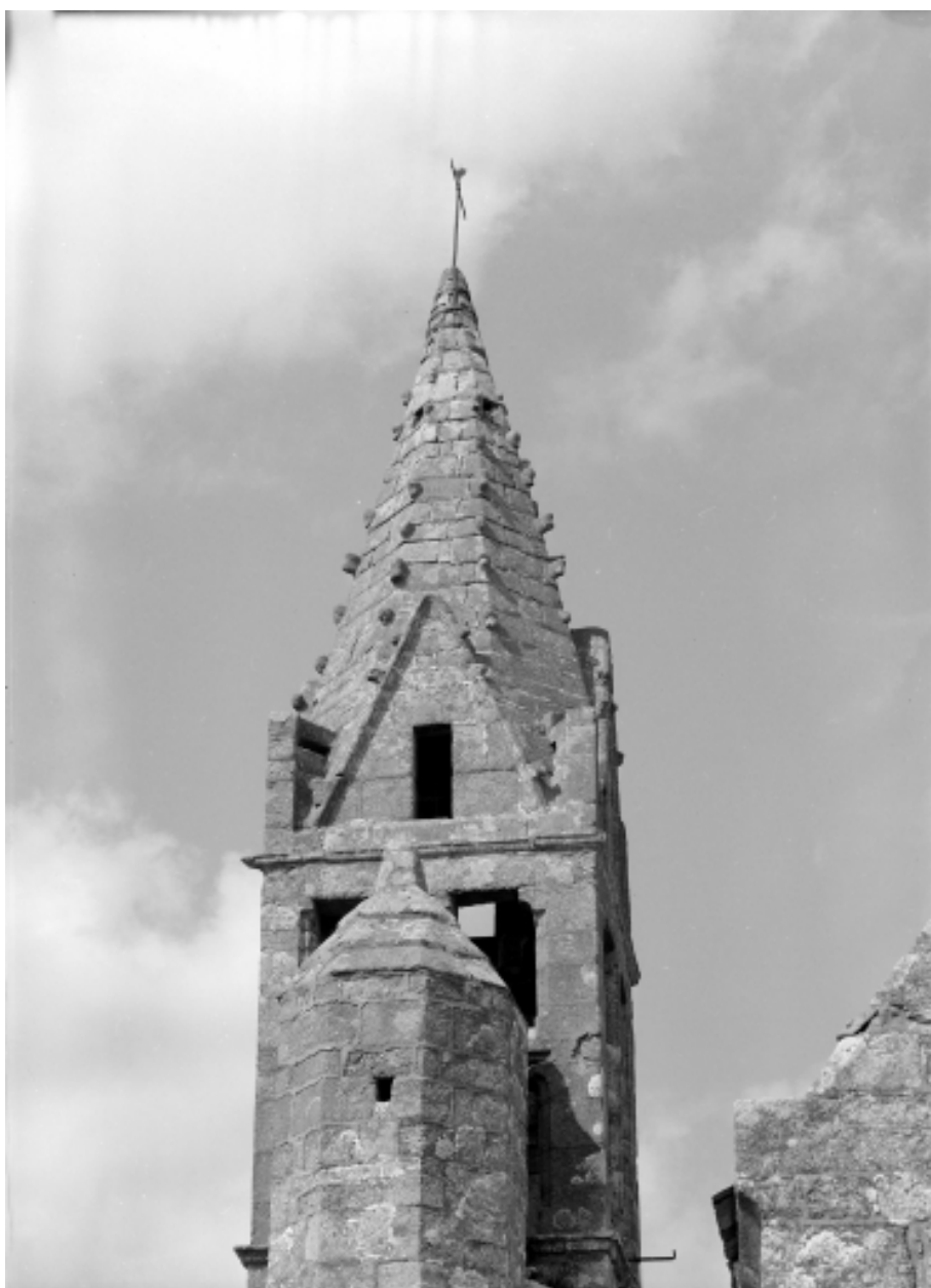
Chambre des cloches et tourelles d'escalier, face sud
