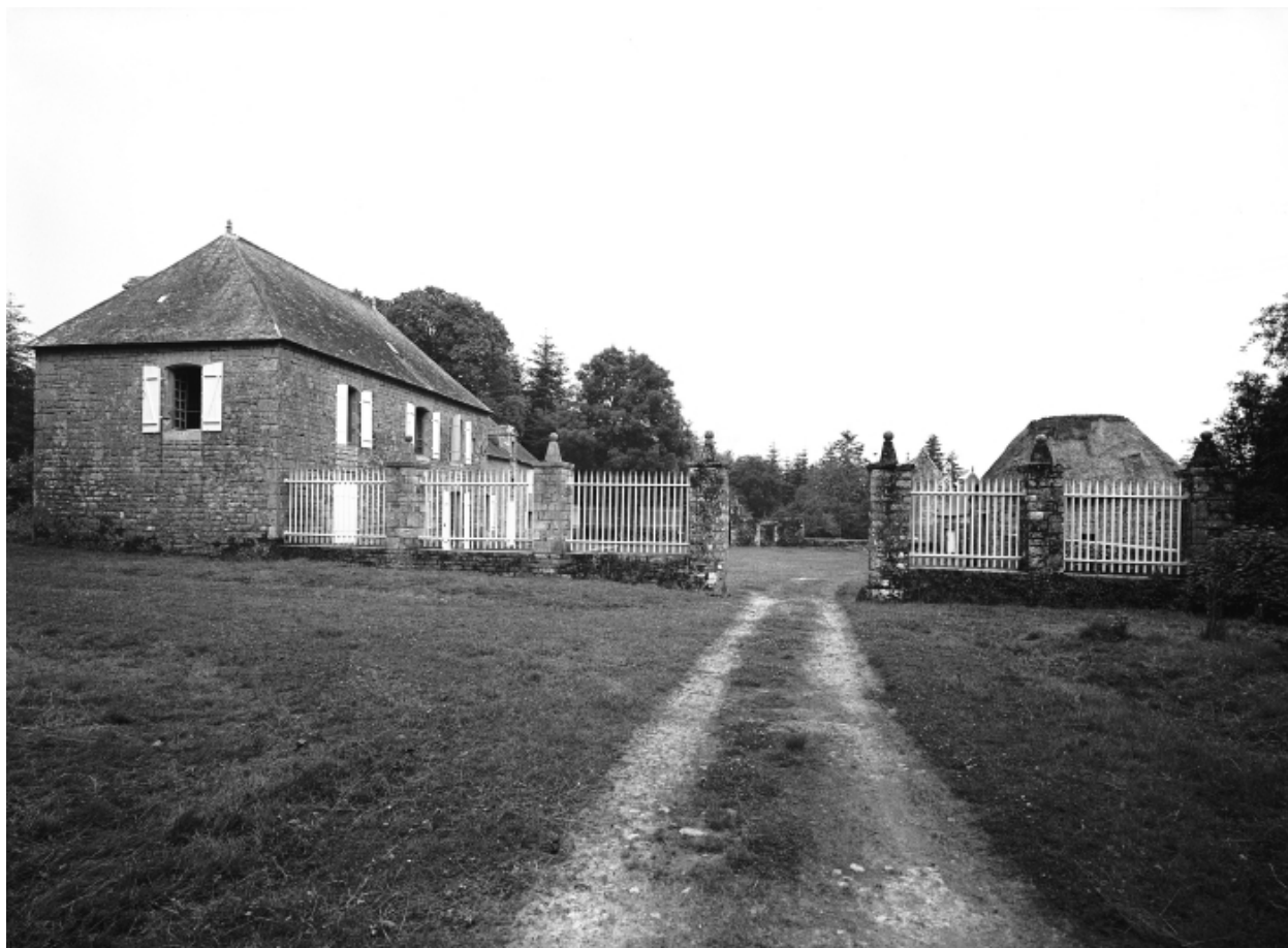
Vue générale de l'entrée principale
