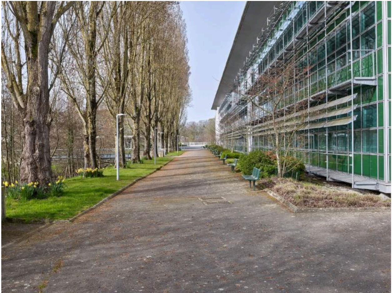
Vue d'ensemble de la façade sud et de l'allée, le long du canal de décharge de la Vilaine. Joël Y. Gautier, architecte, 1992.
