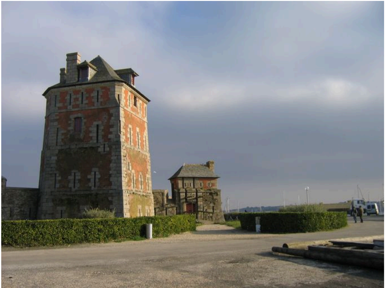
Vue de la Tour Vauban avant restauration
