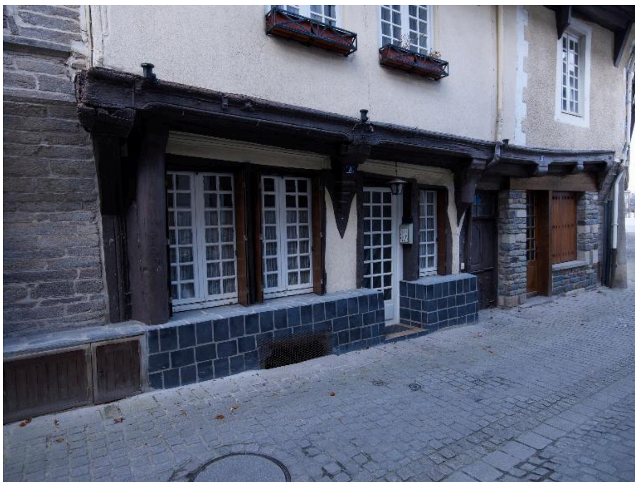
Maison : élévation principale vue du sud-est (état en 2012)
