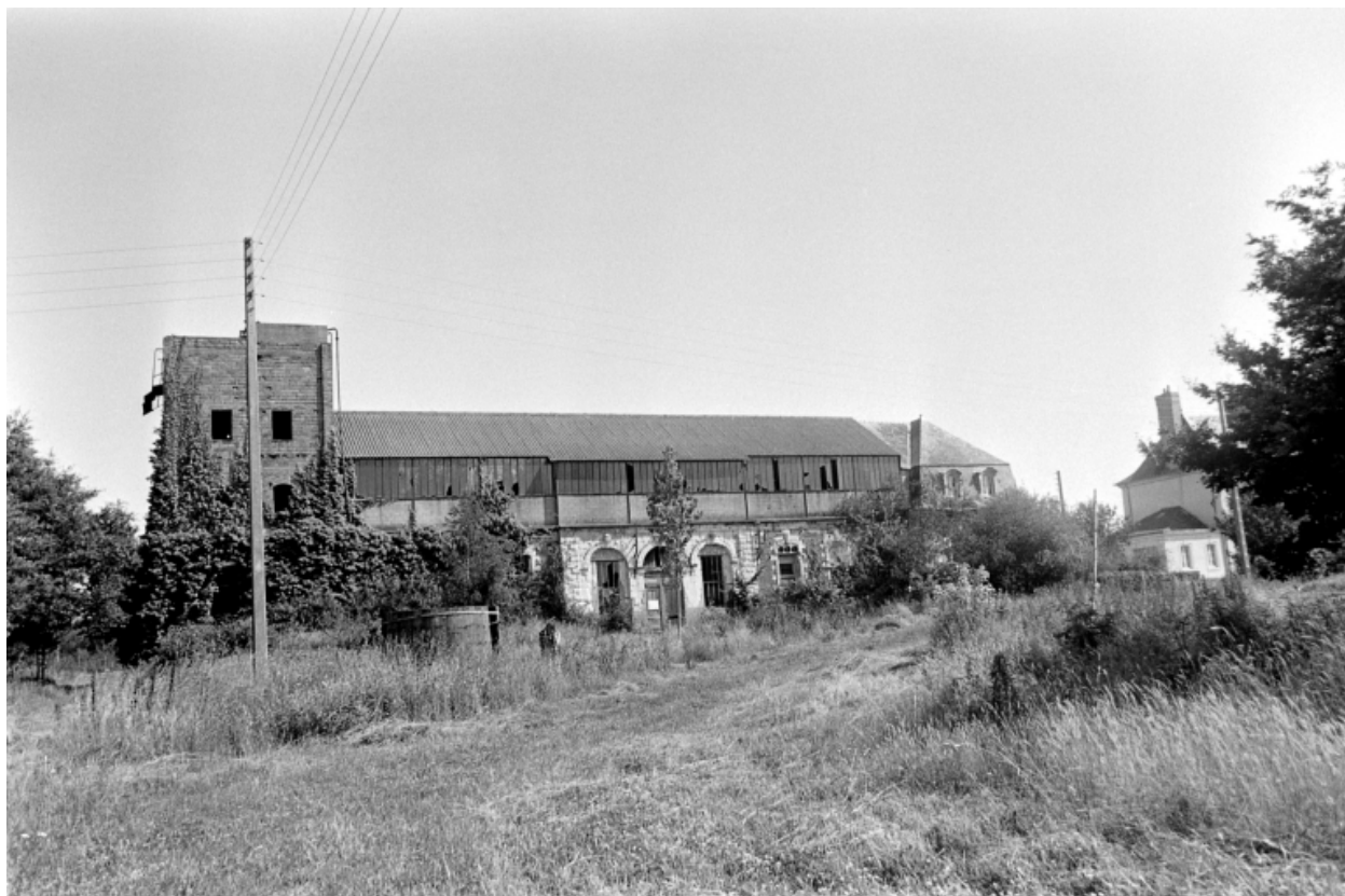
Vue générale sud ; état en 1982
