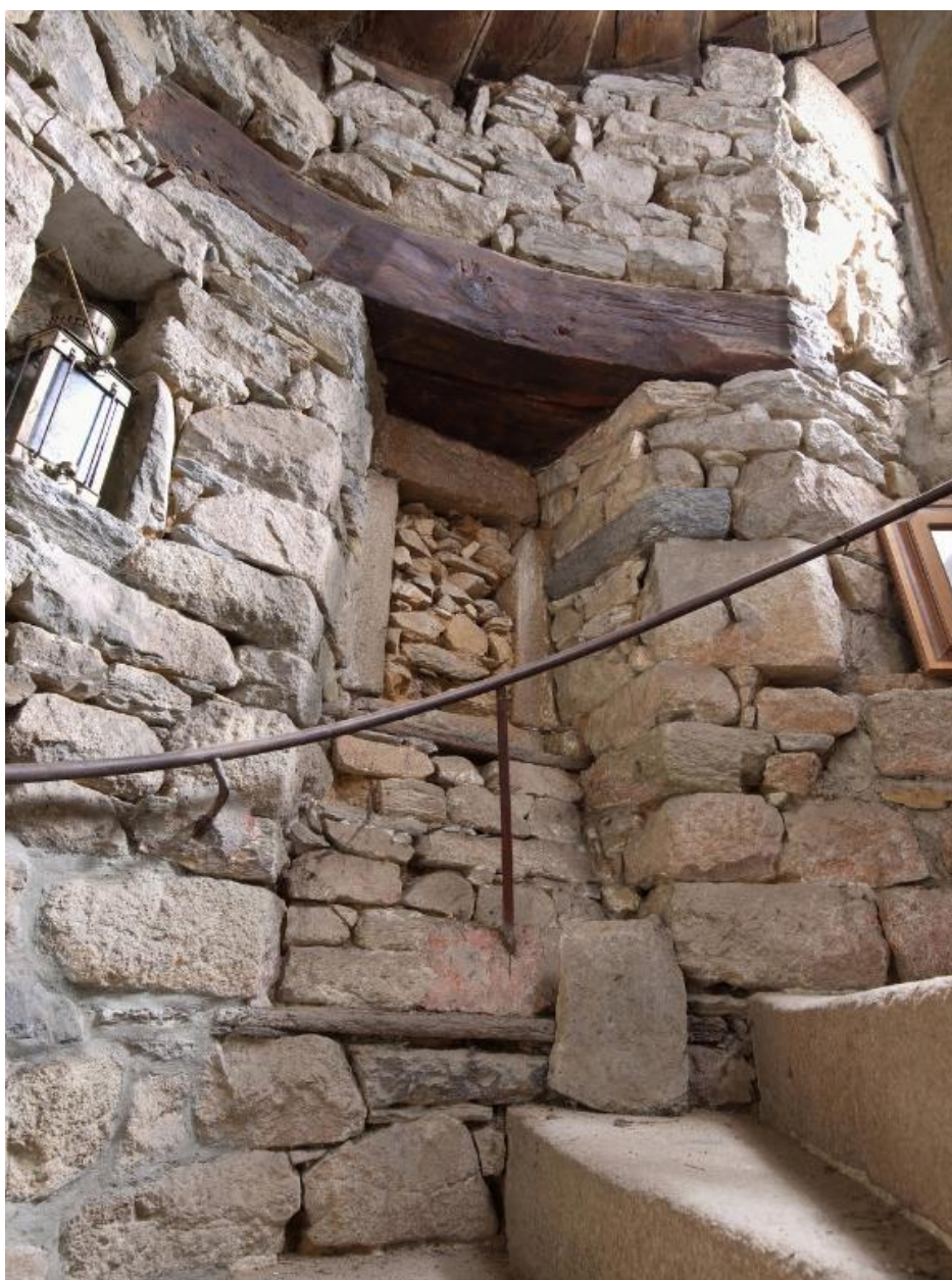
Tour d'escalier. Vue intérieure. Détail d'un jour bouché
