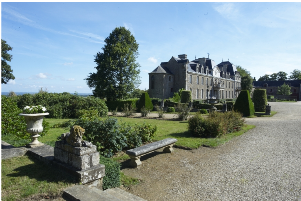
Le château, vue générale de trois quart
