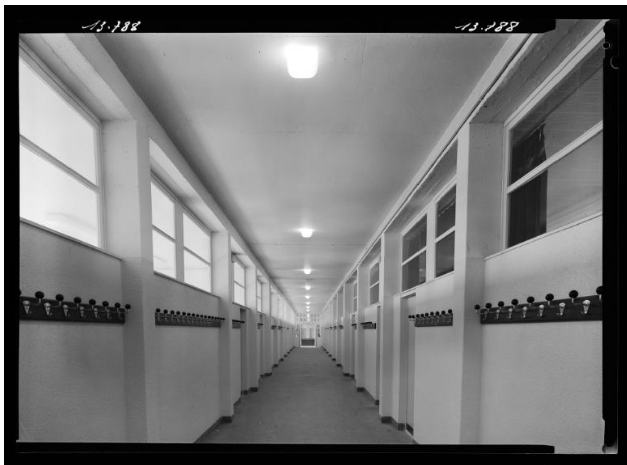
Un couloir central. Photographie Heurtier pour la société EGELEC, avril-mai 1967.
