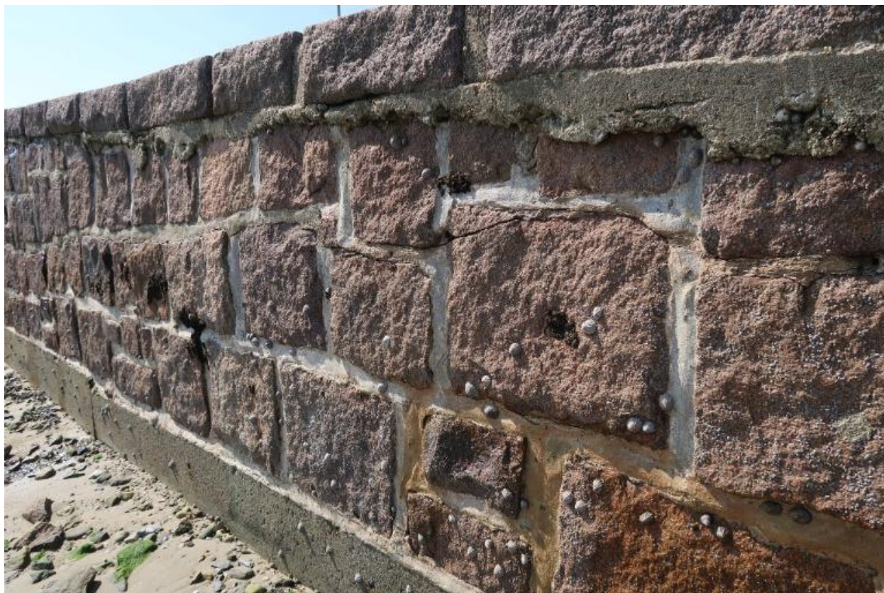
Maçonnerie de granite rose de la cale et du quai d'Auxerre
