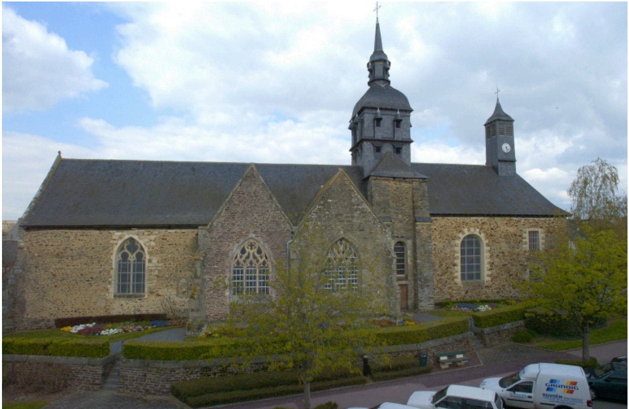
Vue générale sud
