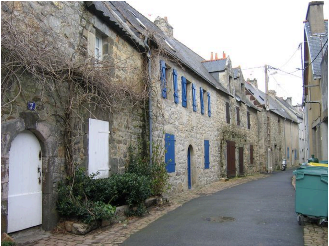
Vue de l'alignement des maisons de la rue de Dixmude
