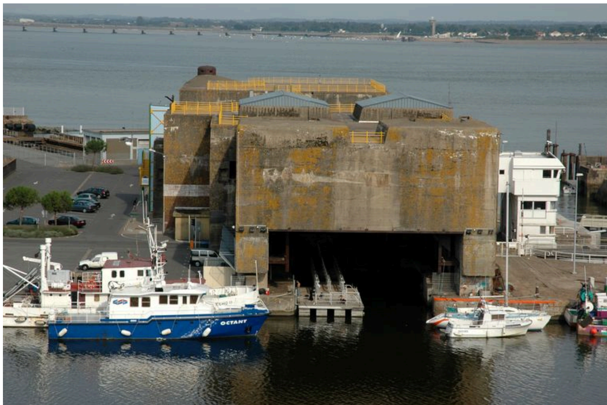
Vue de l'écluse bétonnée et fortifiée de la base de sous-mains de Saint-Nazaire
