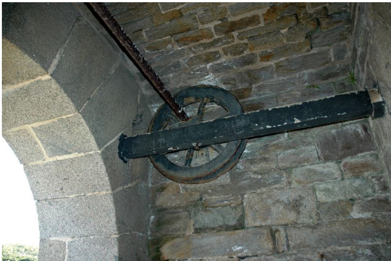
Vue du passage d'entrée : vestiges du pont-levis à contrepoids (état en 2004)
