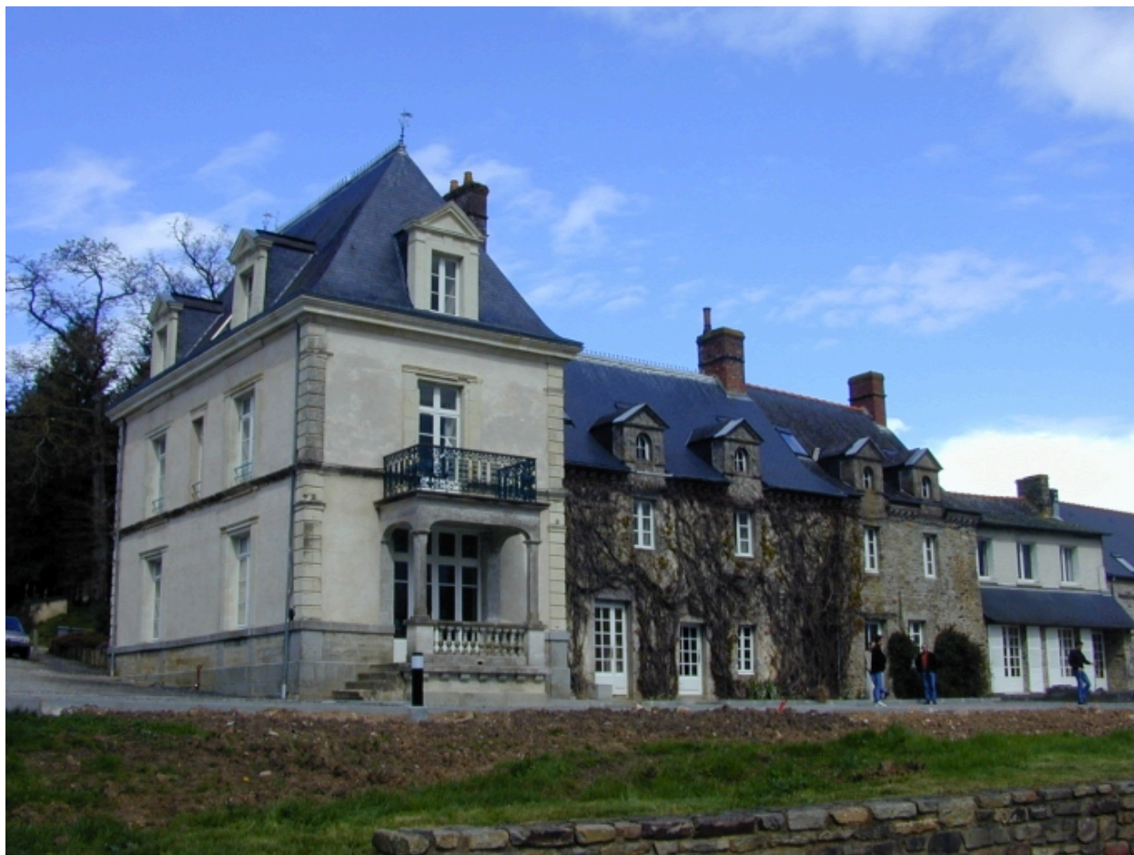
Le corps de logis : vue générale sud-ouest
