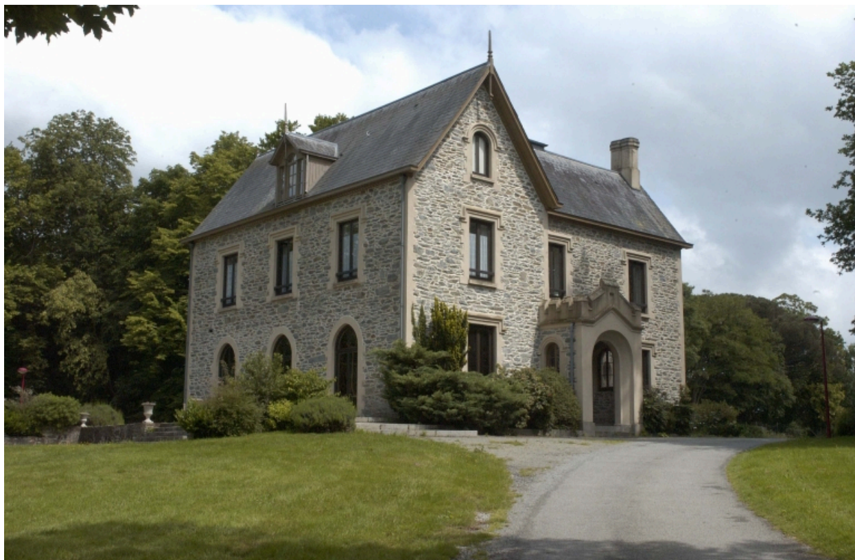
Vue générale de la façade principale
