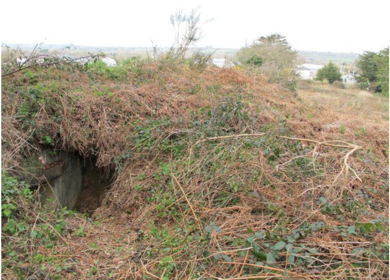
Vue de l'entrée est en partie remblayée et envahie par la végétation (état en 2013)
