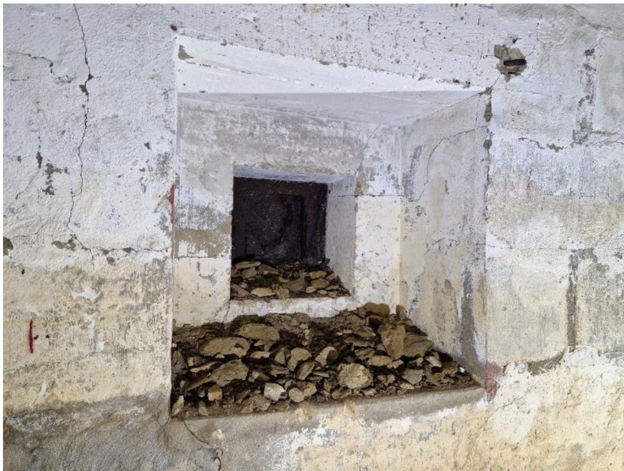
Vue intérieure : créneau blindé défendant l'accès sud
