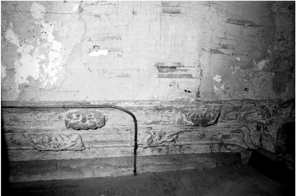
Sixième travée nord, sablière.
