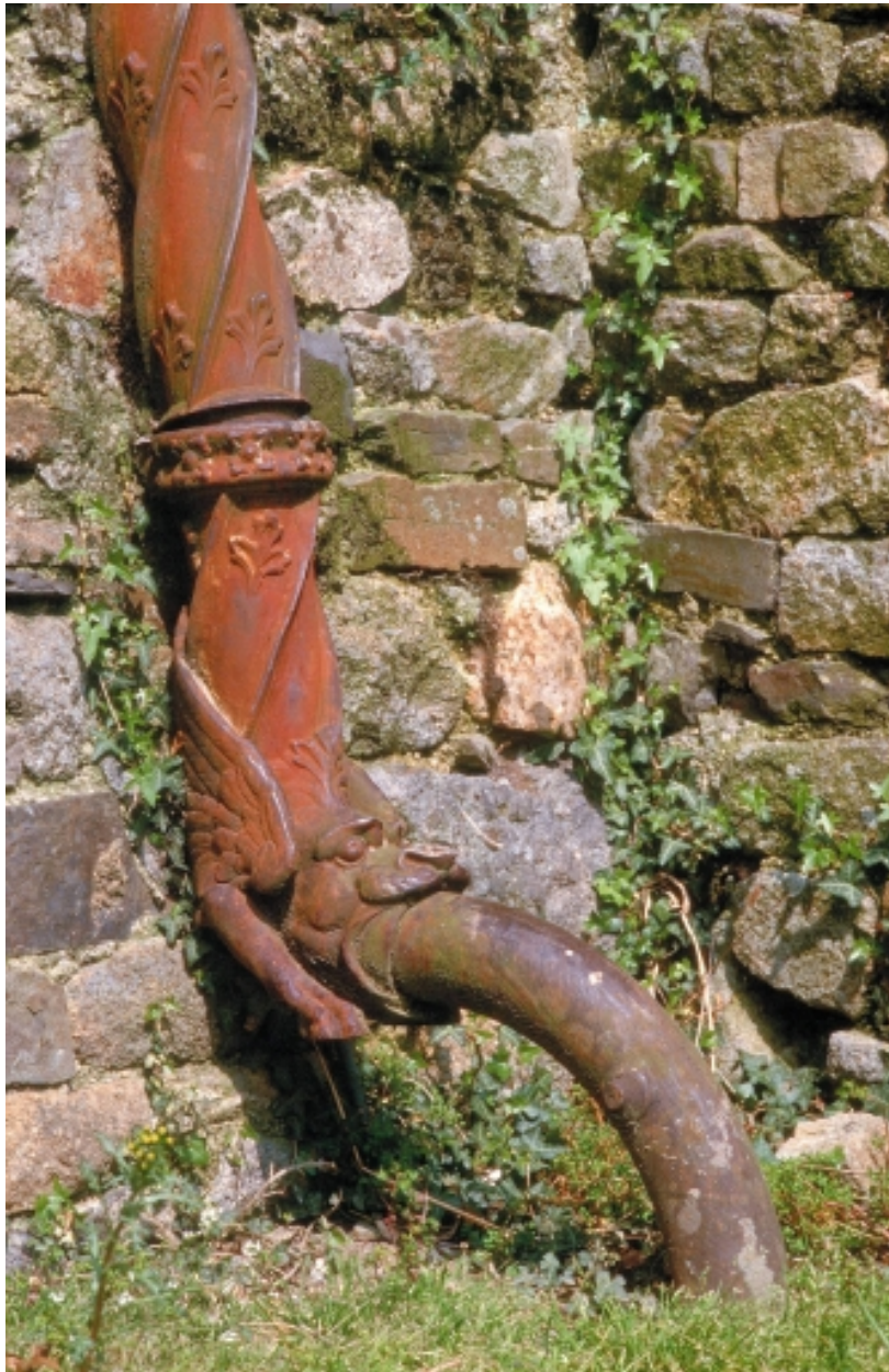
Détail ; descente de gouttière
