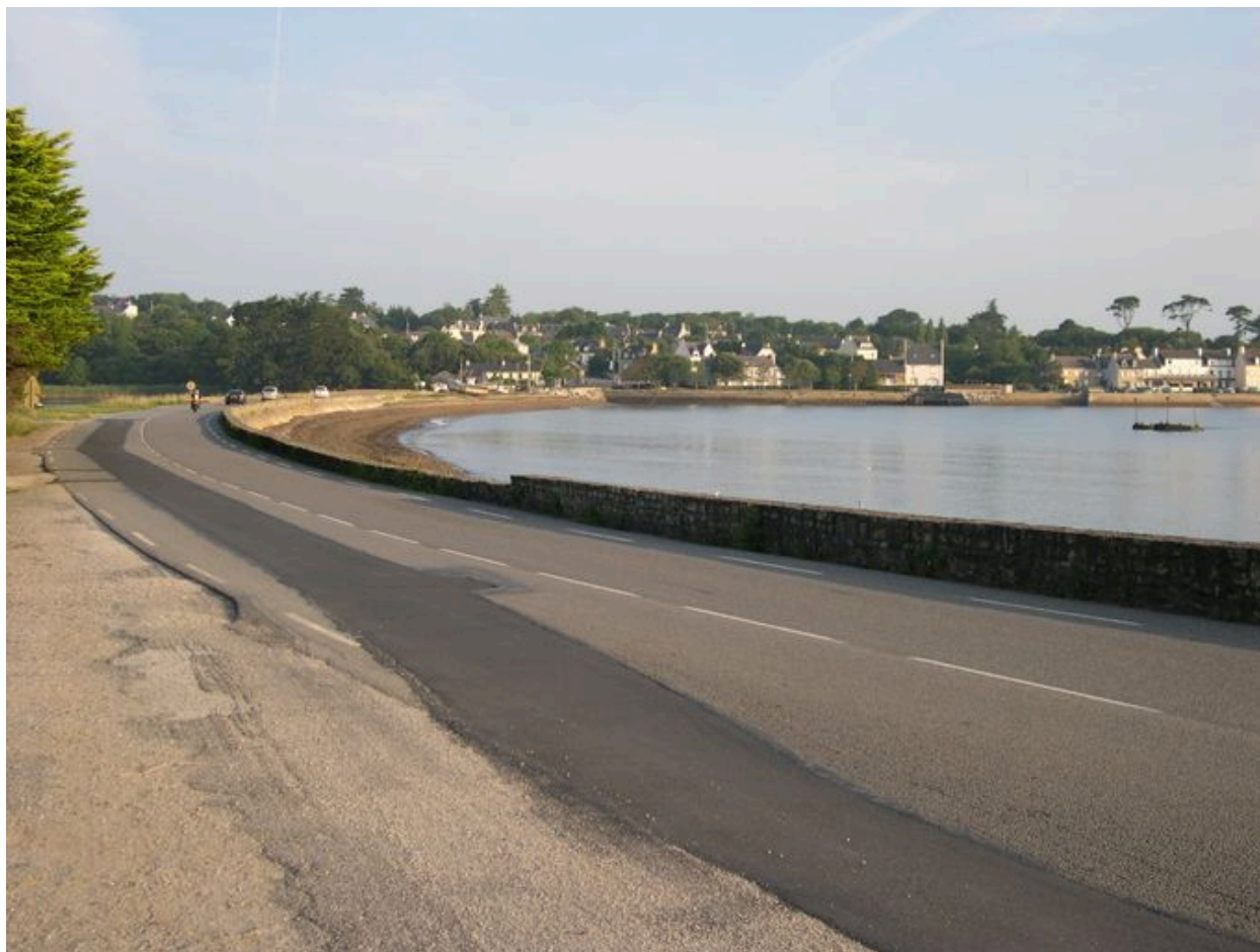
Vue de la digue-route du Sillon et du Fret
