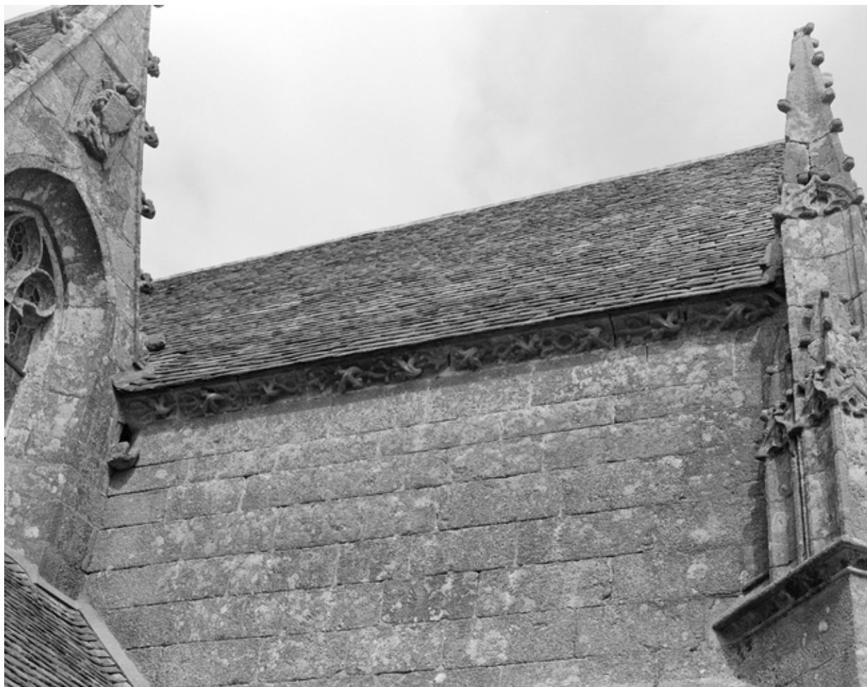
Porche sud : vue de la corniche sur le mur ouest
