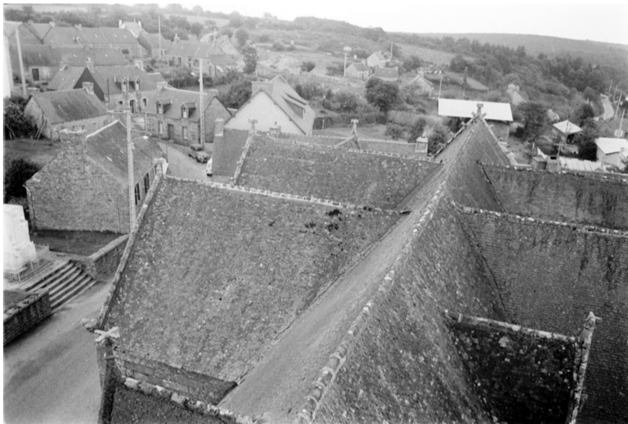
Vue générale vers le nord est
