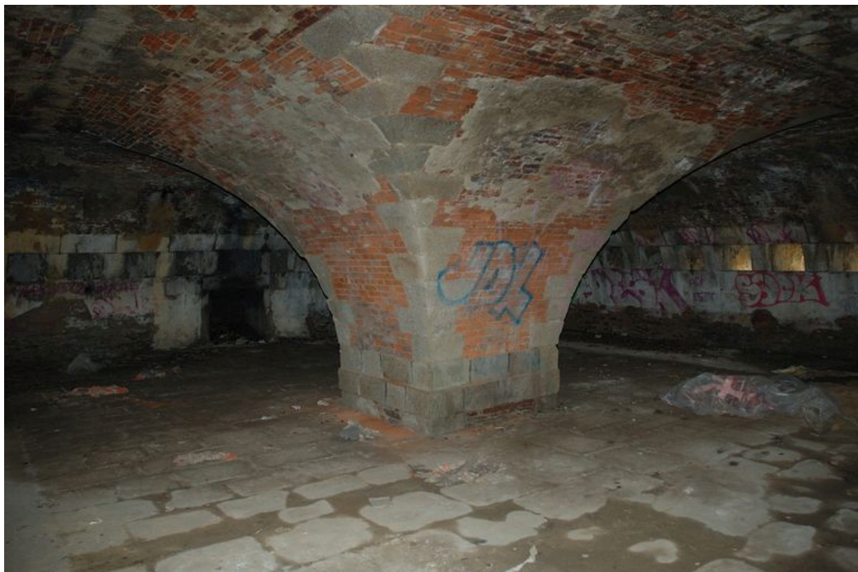
Roscanvel, pointe de Cornouaille : tour-modèle n° 1, deuxième niveau voûté en briques, pilier central
