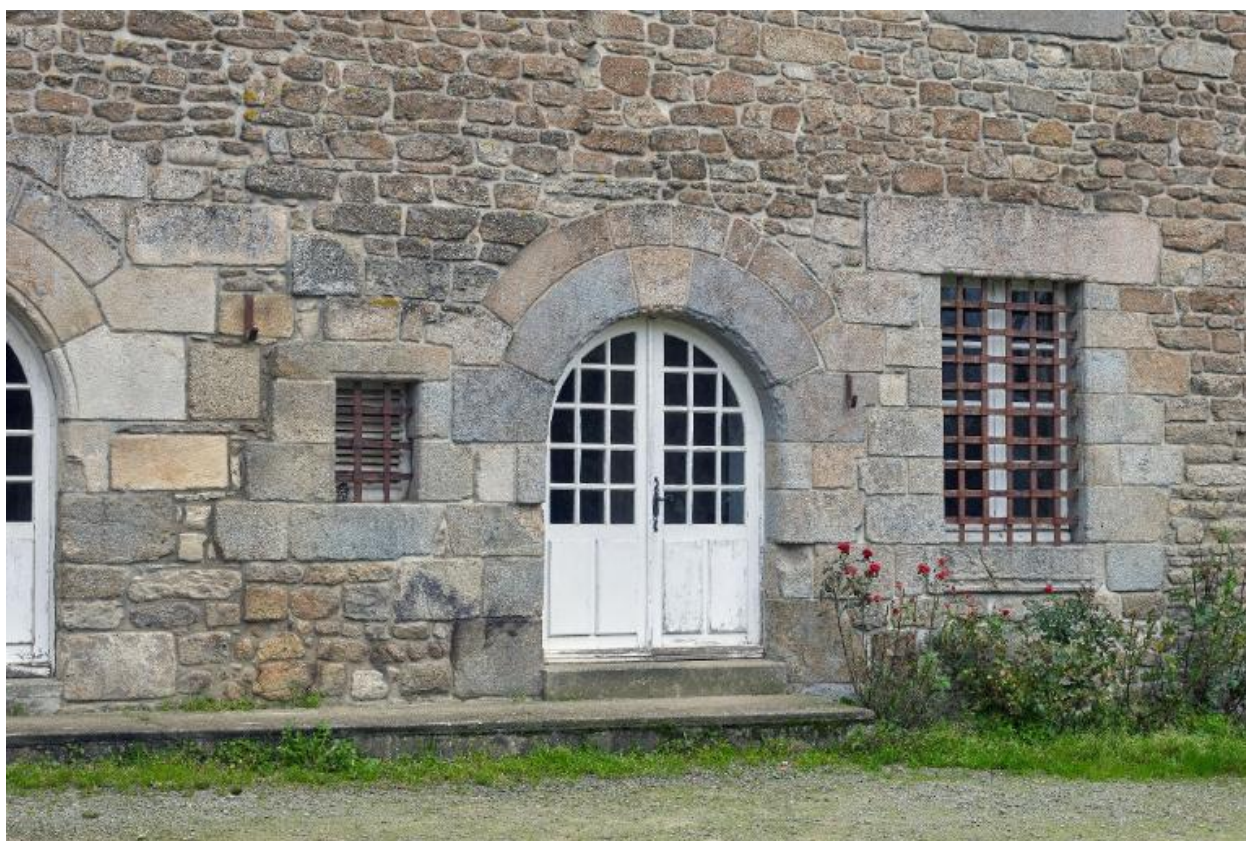
Façade est. Porte et fenêtre de la salle
