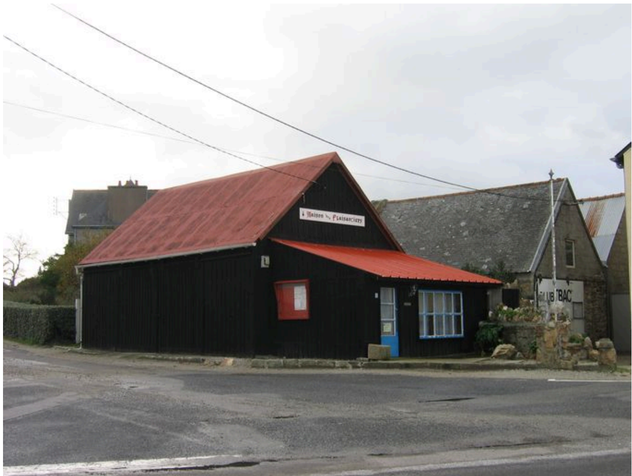
Vue d'ensemble de la Maison des Plaisanciers
