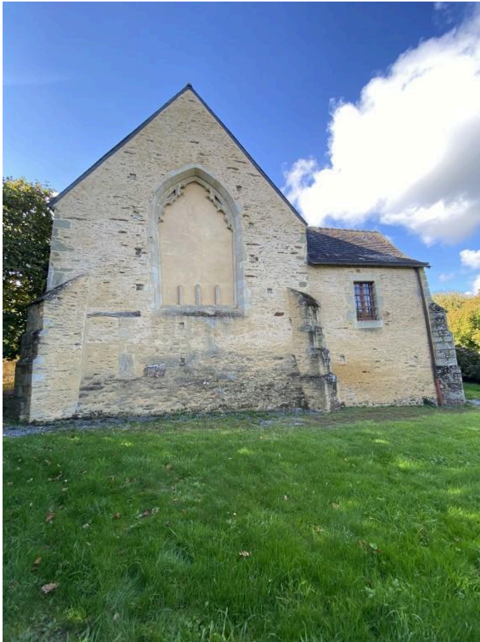
Élévation est, vue générale
