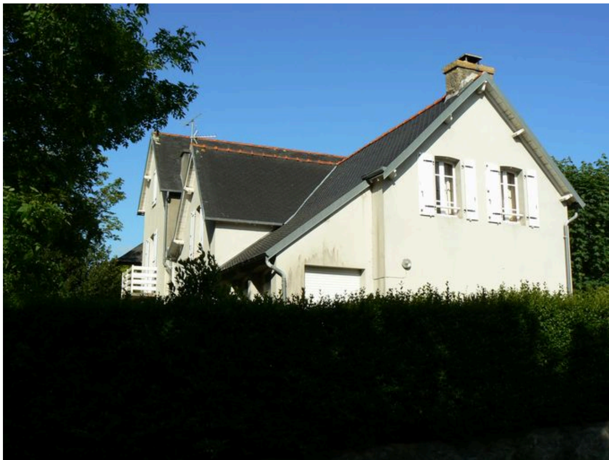
Pignon d'une des villas Les Petites Gares
