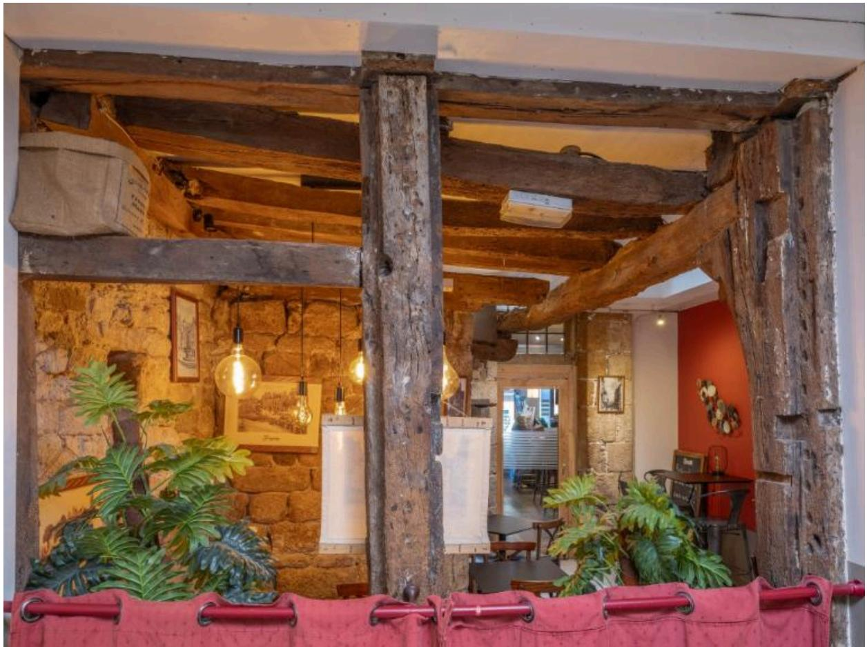
Poteau à tête élargie avec différents traces d'assemblages. Les feuillures sur le poteau de gauche indiquent que nous sommes à l'intérieur de l'ancien bâtiment.
