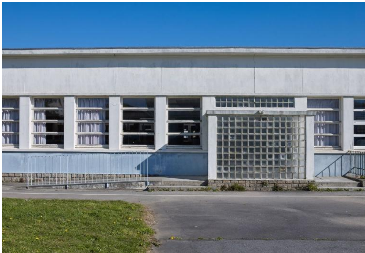
Réfectoire, façade sud, détail sur une entrée et le mur en pavés de verre du sas. J-B. Mathon, architecte.
