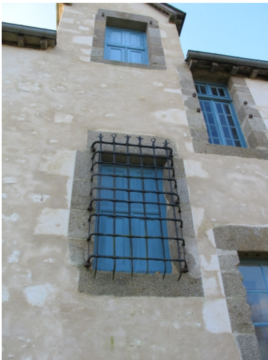
Détail des baies de la façade nord
