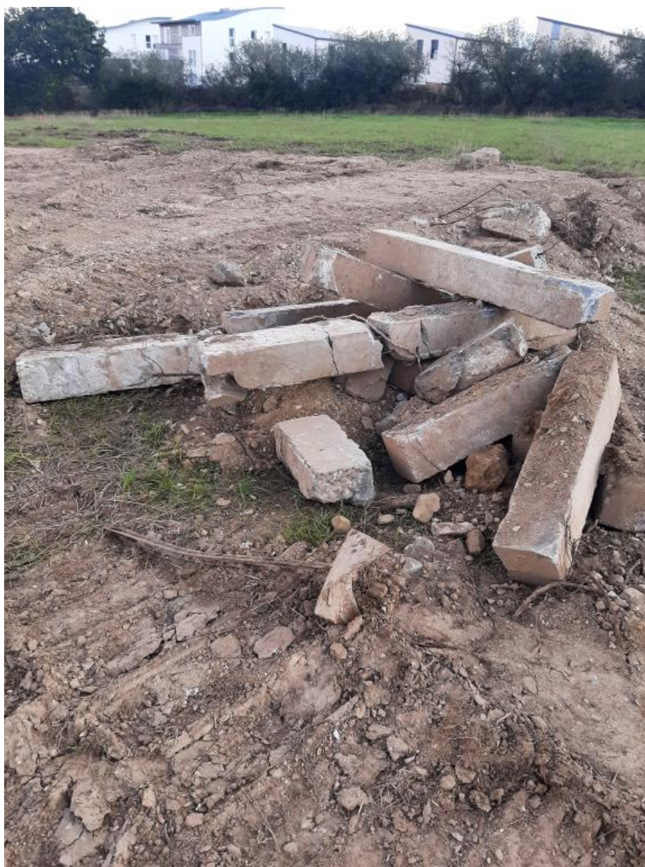
Vue de la déconstruction : poteaux en béton armé (25 septembre 2022)
