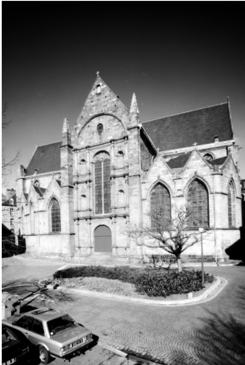
Elévation sud, vue générale
