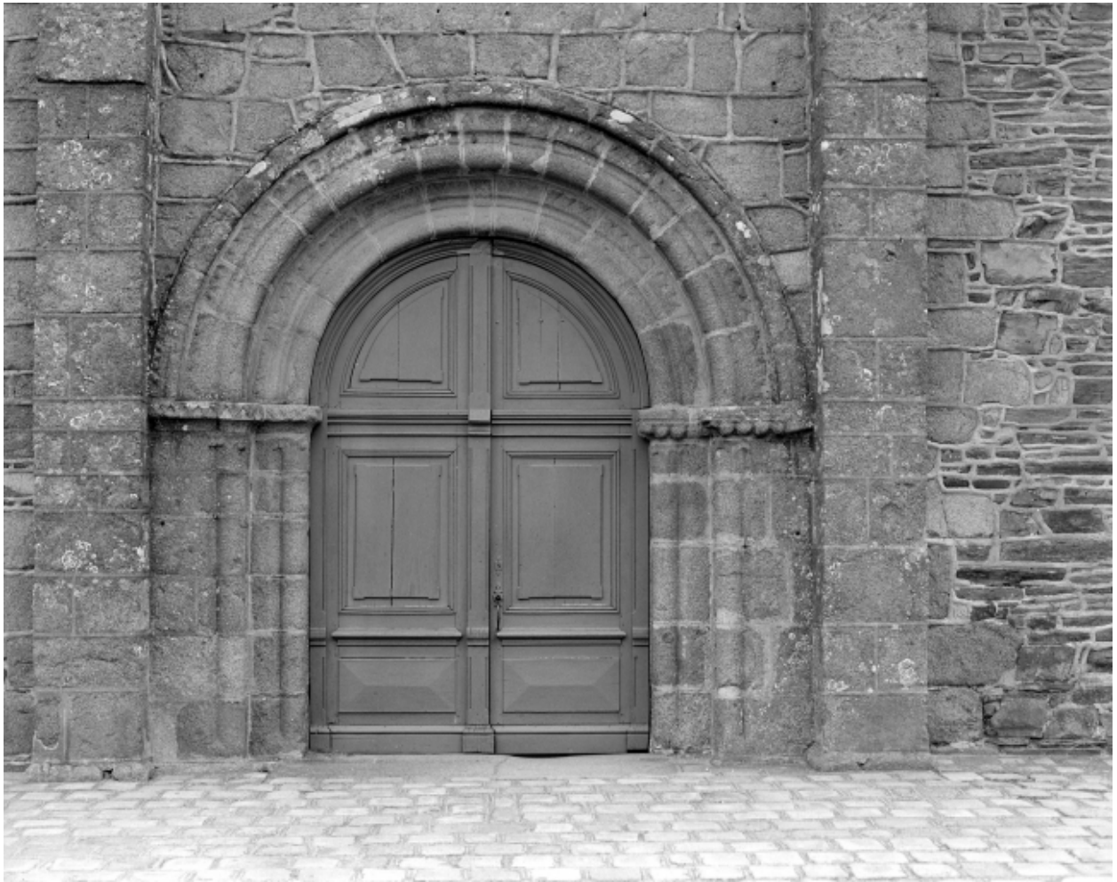
Elévation Ouest, portail : vue générale
