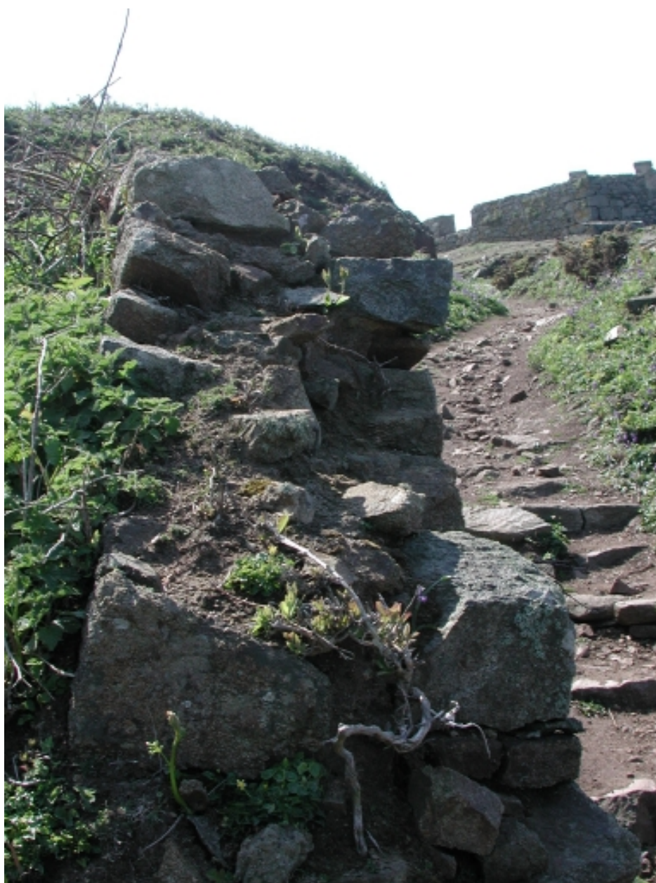
Vue d'un muret effondré : remarquer les grosses pierres utilisées
