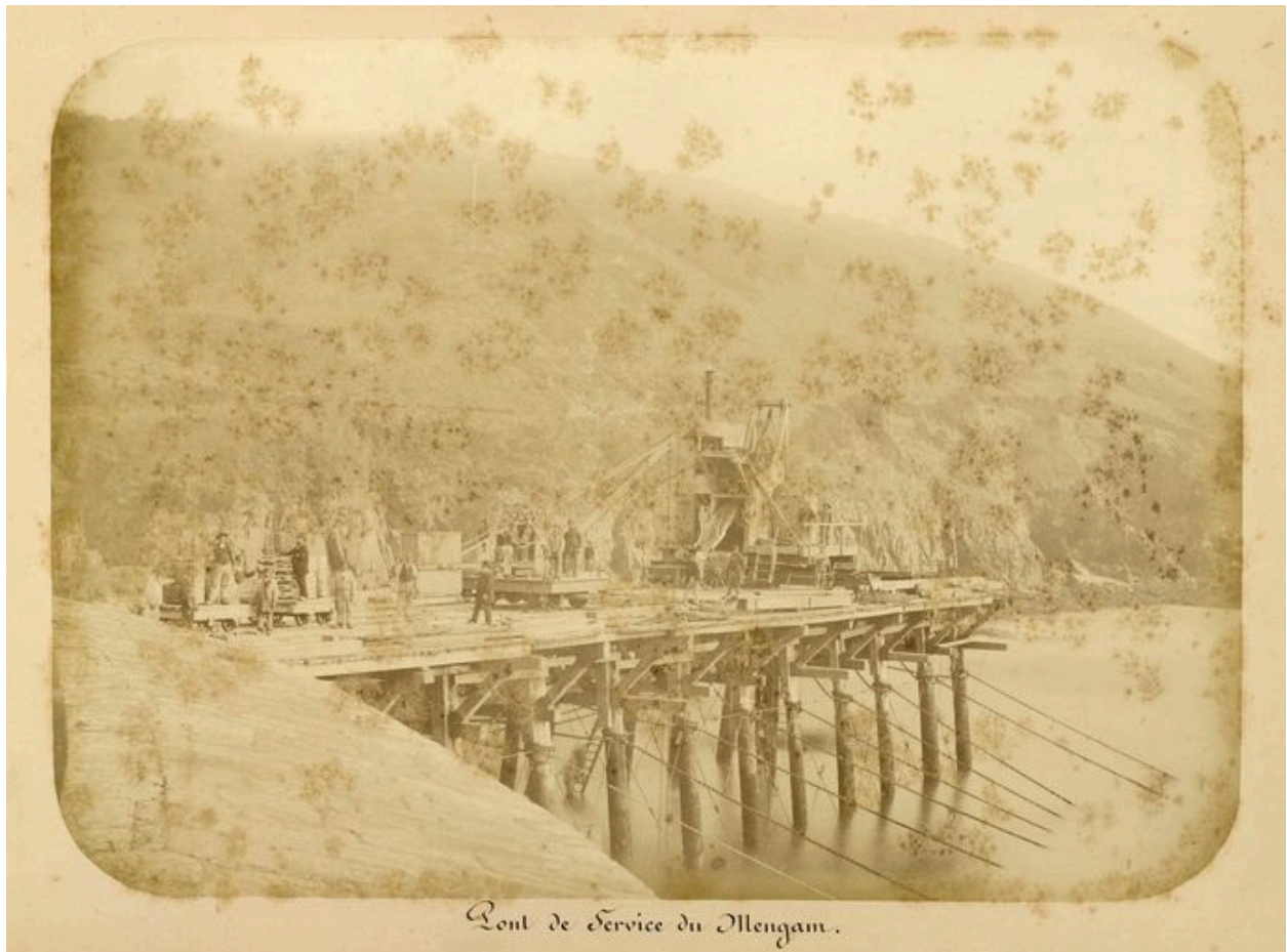
Vue du fort du Mengant en 1877 : chantier de construction du môle d'accostage
