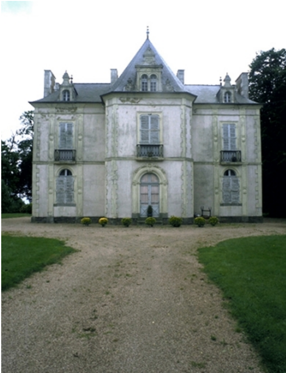
La façade principale : vue générale nord
