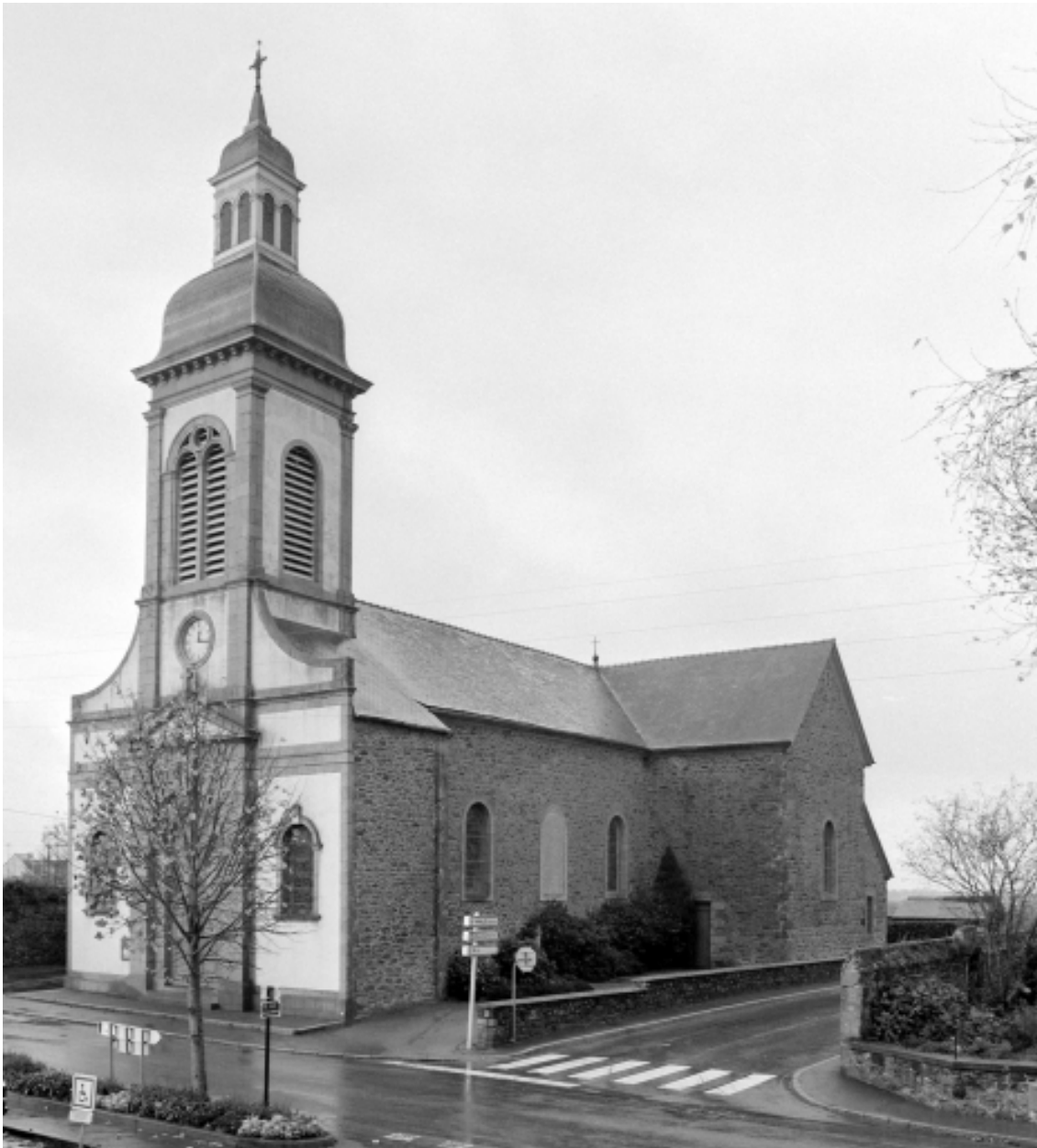
Elévation Sud-Ouest : vue générale
