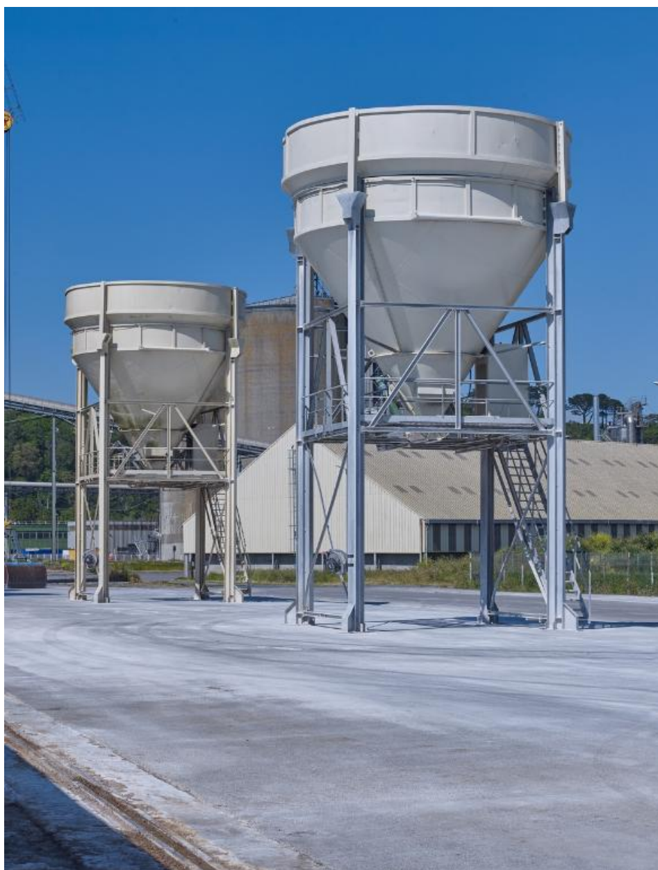
Trémies sur le quai minéraliers du 6e bassin
